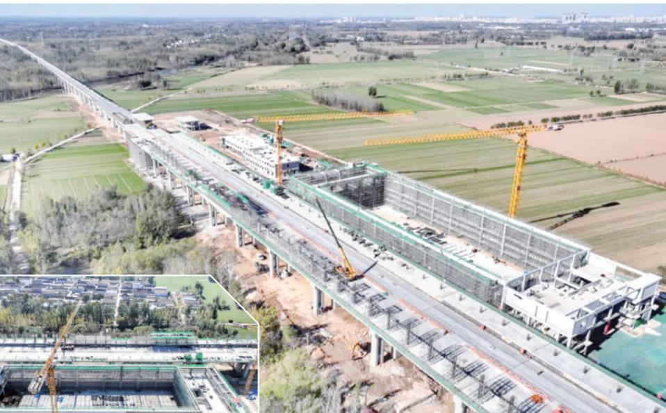
济滨高铁线路全长145.3公里，设计时速350公里，全线共设6座站房，新建站房4座。惠民站是惠民县首个铁路客运站房，建筑面积1万余平方米，属于线侧下式站房，设站台两个，站台雨棚面积7200平方米。站房地上一层，局部设夹层，地下局部一层。
