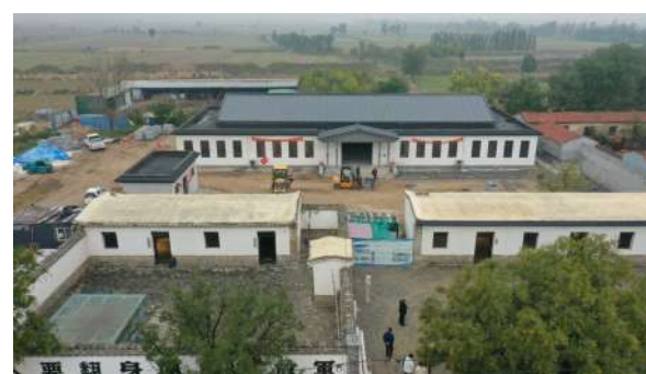
位于阳信县商店镇老观王庄的山东渤海军区教导旅成立旧址展馆。
