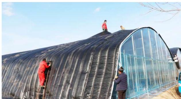
近日,在沾化区黄升镇大新村沾化冬枣新品种冬枣示范推广基地建设现场,最后一块棉被安装完毕,标志着钢结构冬暖式棉被大棚正式
