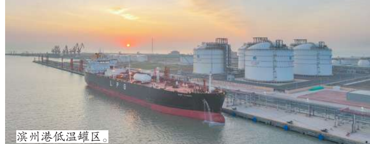
滨州港低温罐区。
