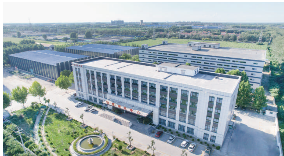
麦麦时装智能仓储配送中心项目。
