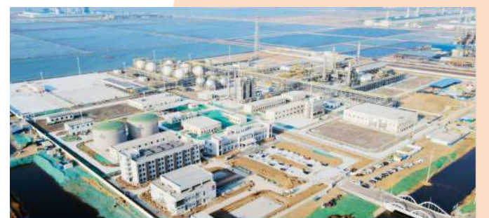
渤中19-6凝析气田1期开发项目滨州天然气处理终端竣工投产
