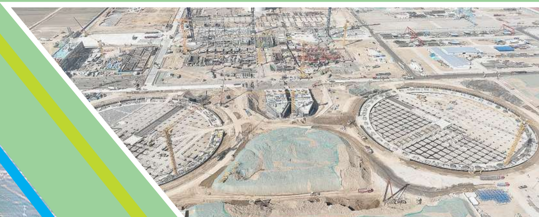
一期项目施工现场。
